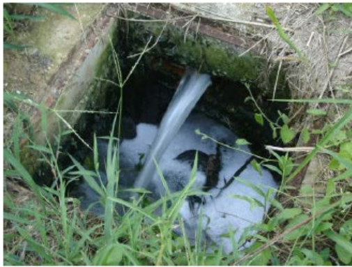
ข. บ่อพัก (Manhole) รับน้ำทิ้งผ่านการบำบัด
