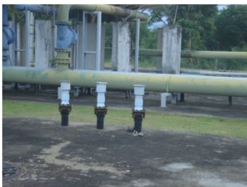
จ. เครื่องเติมอากาศแบบ Air Blower
