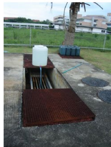
ฉ. ระบบฆ่าเชื้อแบบเติมคลอรีน
